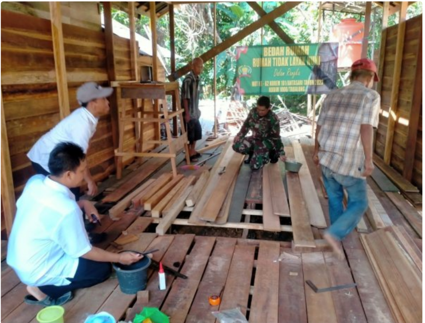
Kodim 1008/Tabalong Rehab Rumah Warga Tidak Layak Huni
